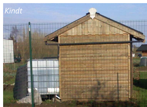
Kindt Matériel à fournir : un abri, une cuve de récupération des eaux de pluie et un composteur. Jardin communautaire de Bailleul (59)
